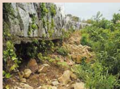
▲掘削されたメキシコ記念塔石積み
