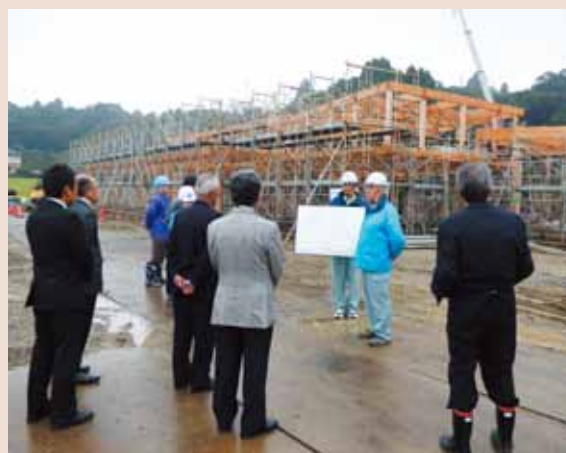
▲認定こども園建設現場
