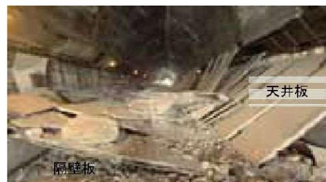
写真-4 天井板崩落状況②
