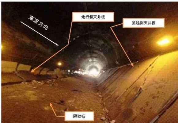
写真-3 天井板崩落状況①
