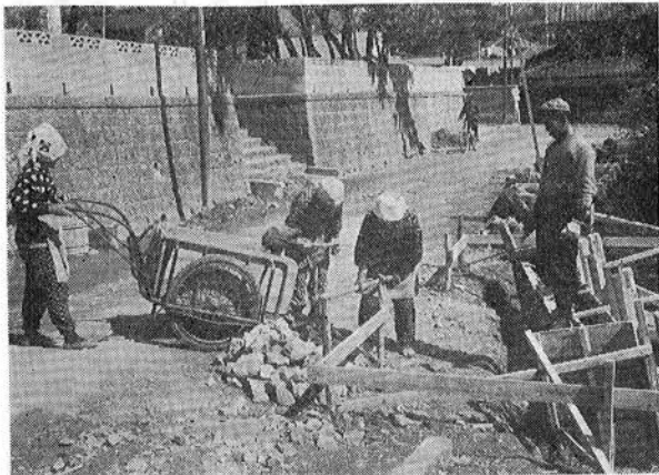
〔写真〕 この道も、もうすぐ舗装される
