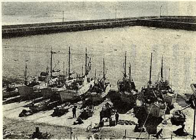
改修工事が行なわれる岩和田漁港
