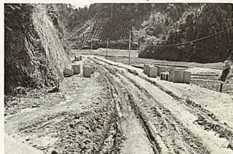
改修される高山田道路
