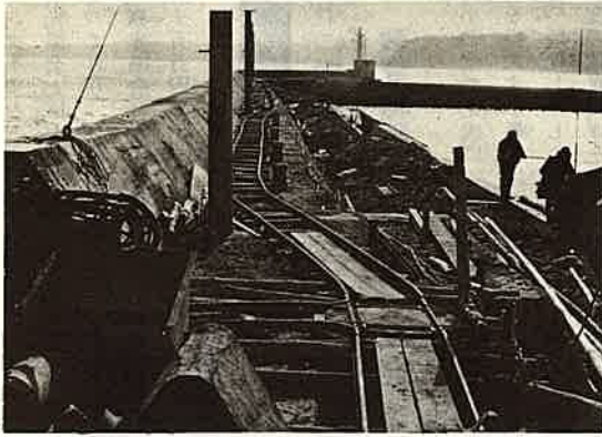
工事中の岩和田漁港
