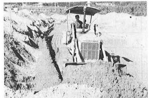
プール建設工事も急ピッチ
