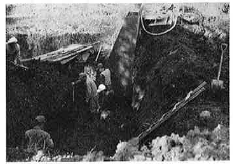
道路新設改良工事の様子
