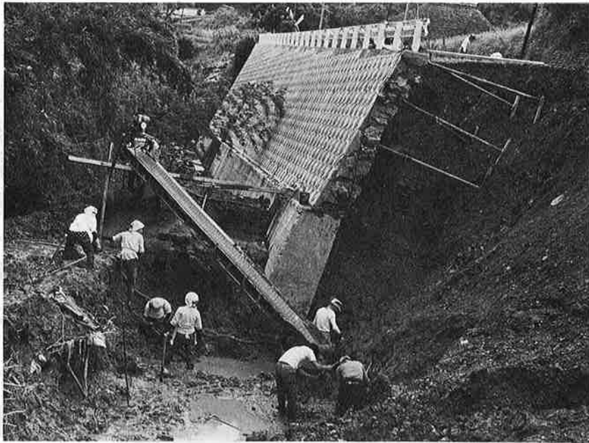
災害復旧工事も軌道に乗ってきた
