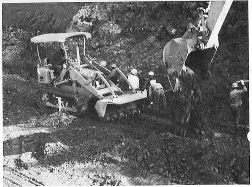
大型機械を駆使して、道路がつくられていく
