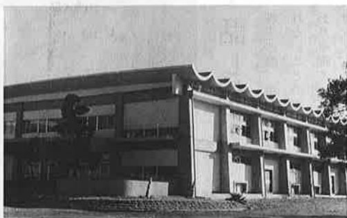
公共施設も火事に強い様に防火建築にしています(御宿小の体育館)
