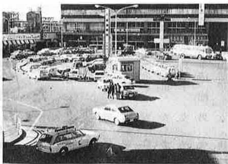
写真 Ⅱ 交差点は排気ガスのため
