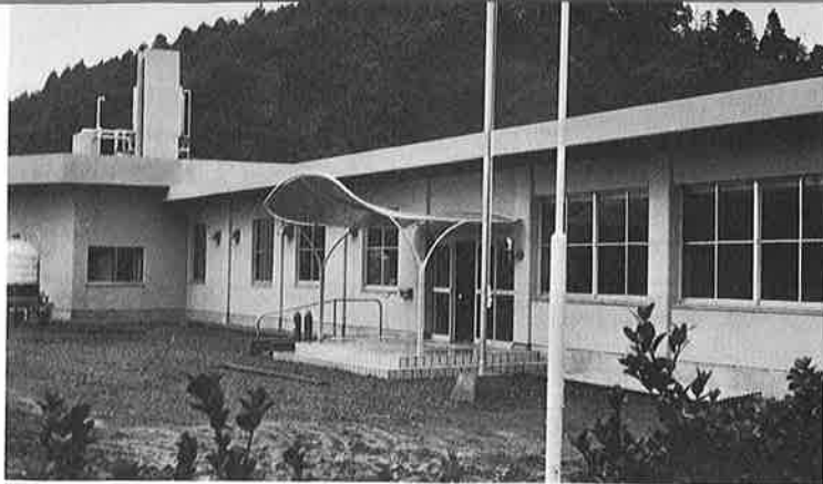
完成した老人福祉センター
