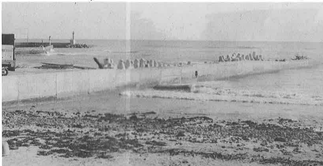
岩和田漁港の防波堤工事 (49年度)
