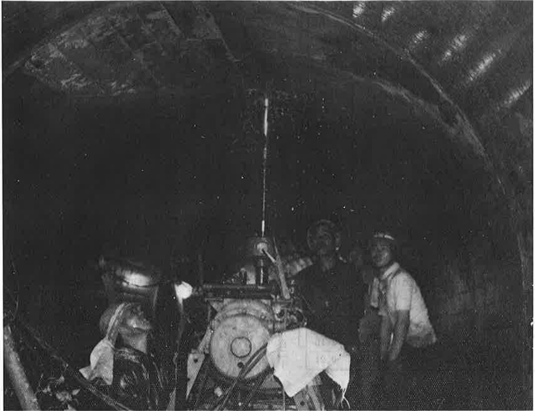
49年度に行った主な事業の一つ 実谷ダムの仮排水路工事
