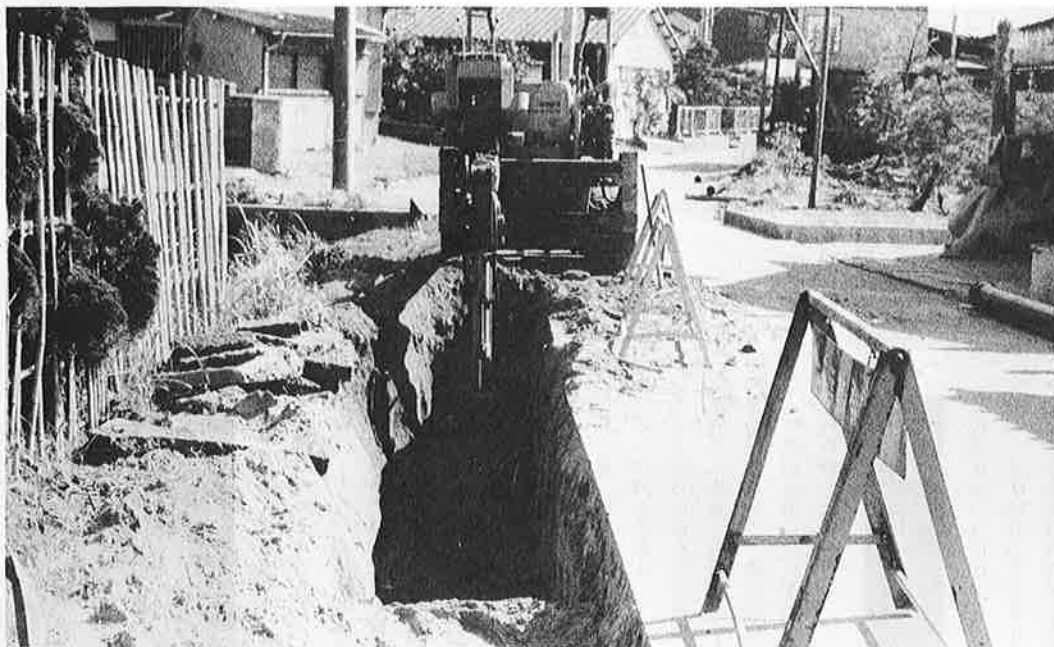
排水管を埋設するため道路の掘り下げがはじまりました
