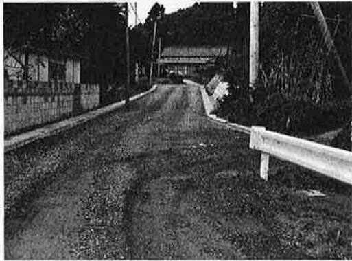
着々進む道路改修工事
