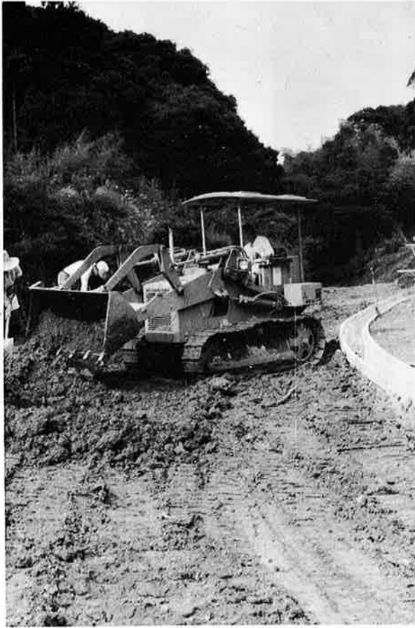
① 順調に進む道路改良工事 ② 岩和田漁港の修築工事
