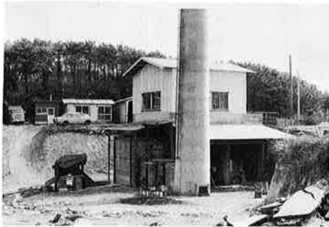
四十四年に建設された処理場
