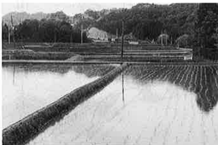
農業の振興（排水整備工事）
