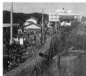
消火作業にあたる消防団員
