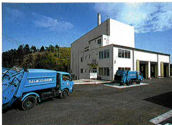
昭和59年 清掃センターが完成
