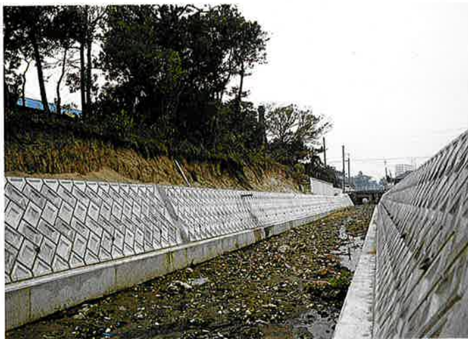
河川の護岸整備
