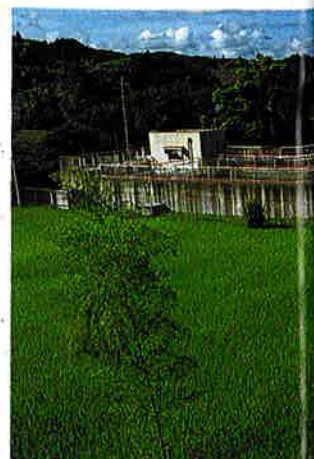
昭和53年 上水道の給水が始まる
