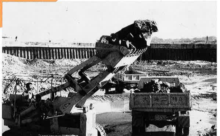
昭和39年 建設が進められる御宿漁港
