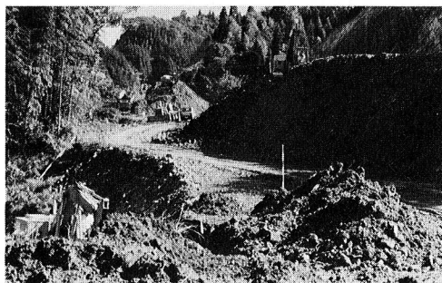
▲急ピッチで拡幅工事が進む(実谷地先)
