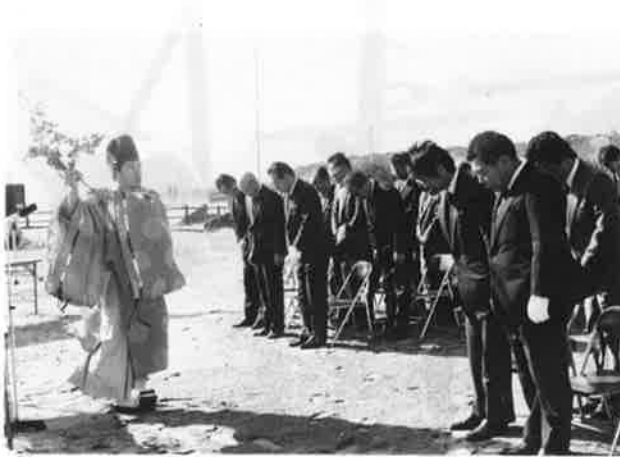
海の保養地にふさわしい施設として着工された月の沙漠記念館。写真は1月31日に行われた起工式。
