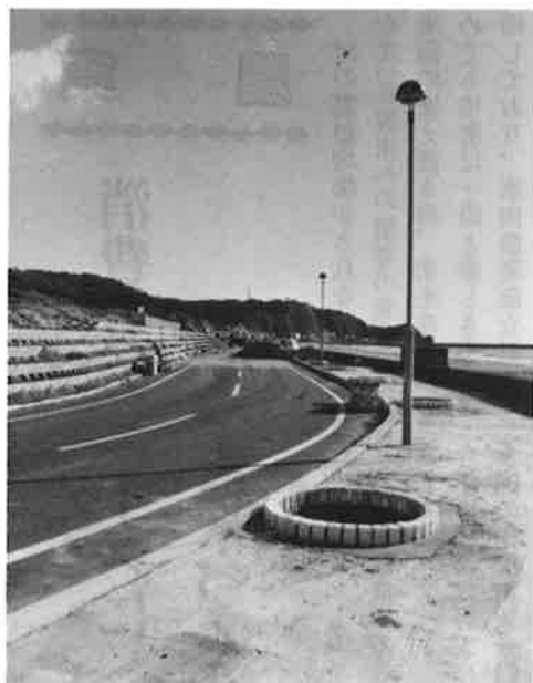
完成間近な浦中地先の海岸道路 引き続き歩道整備を行います。
