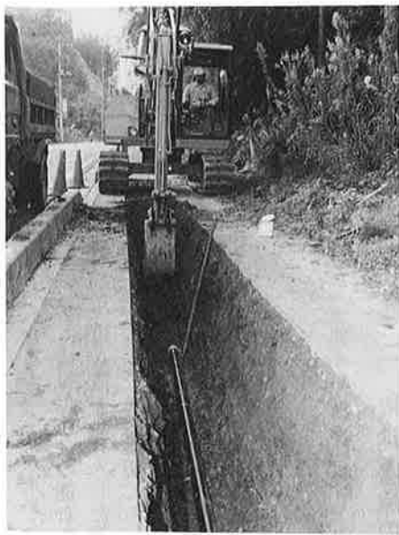
全町給水へ向け、急ピッチで進む本管理設工（高山田地先）
