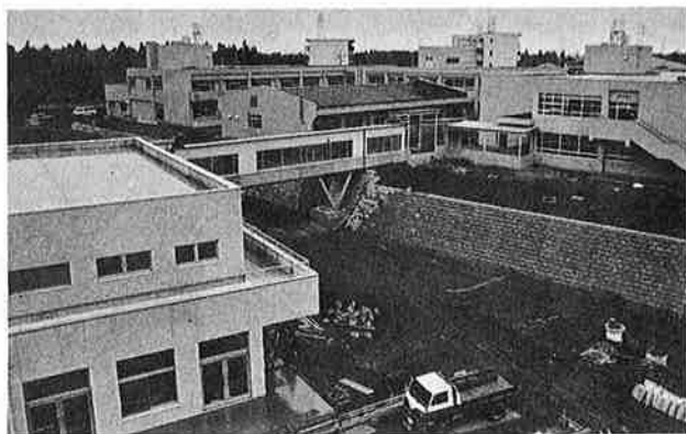
千葉市誉田に4月1日にオープンした千葉リハビリテーションセンター。鉄筋3階建て、1部4階建ての医療から職業訓練までの総合的なリハビリセンターである。
