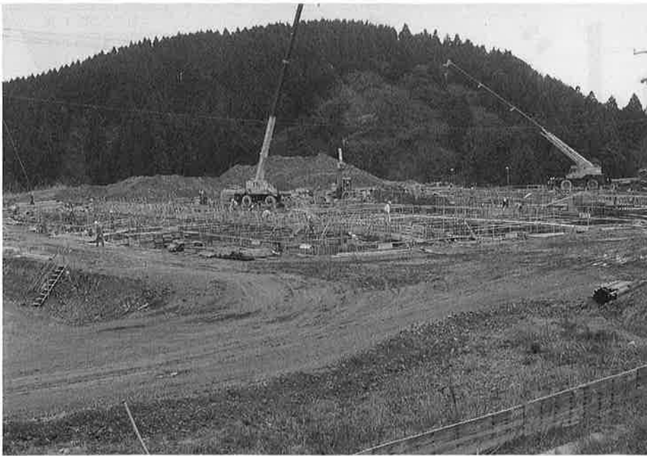
役場新庁舎は、平成5年春の完成を目指し工事が進められています
