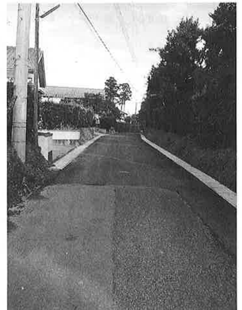
舗装修繕・排水整備された上布施小幡の道路
