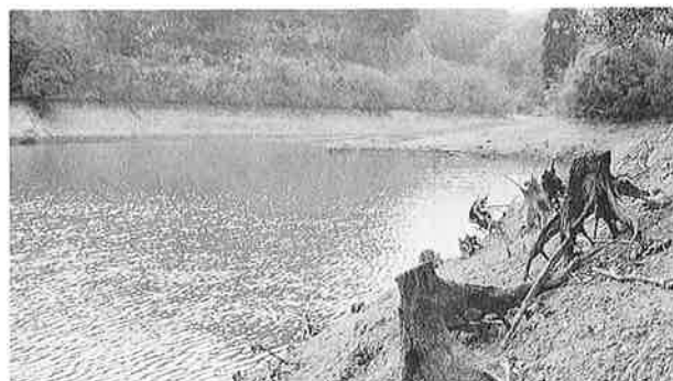
大幅に水位の下がった御宿ダム
