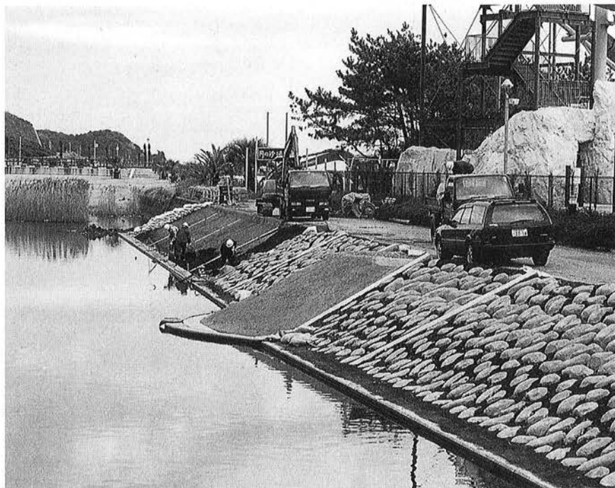
工事の進む清水川整備事業
