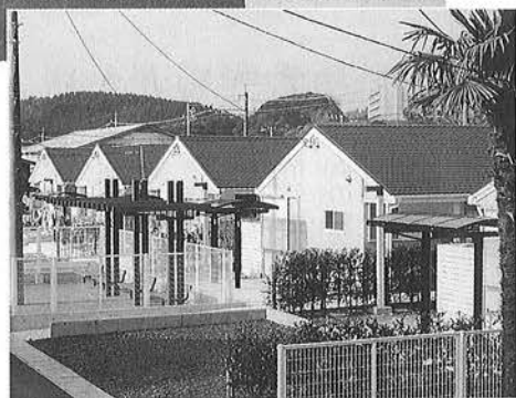
九月に全棟完成した町営富士浦住宅。
