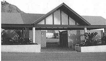
体の不自由な方にも、安心して使用できる岩和田公衆トイレ。人にやさしい施設づくりを実施しました。
