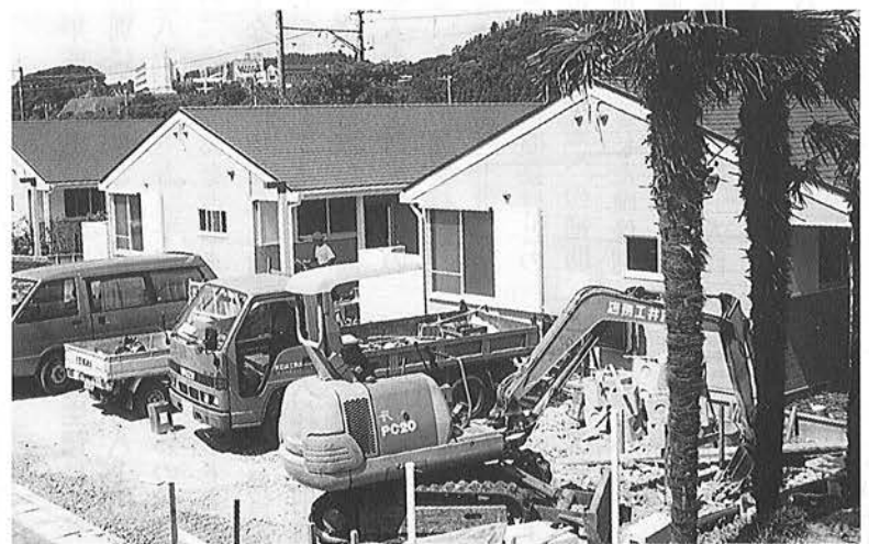
平成9年度から建替えを行なっている町営富士浦住宅。住環境の充実を図ります。
