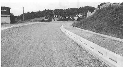
国道128号線から岩和田・六軒町(天の守)地先に接続する町道0109号線。主要幹線道としての効果が期待されます。
