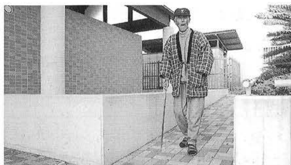
すべての人にやさしい施設整備に取り組んでいます (岩和田トイレの段差を無くした入口)
