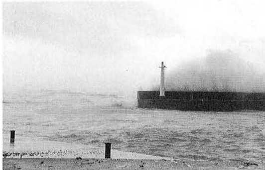
十月十日に発生した集中豪雨は町内の道路や河川などに被害を与えました
