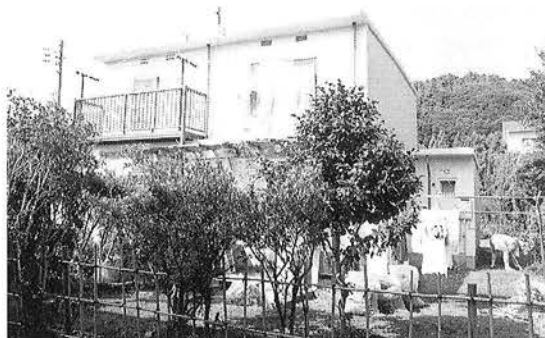
外壁工事等が行なわれた矢田団地
