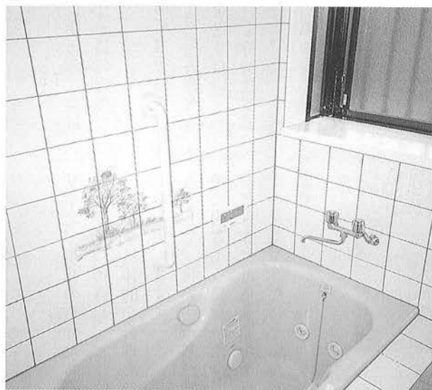
浴室に手すりを取り付けた例
