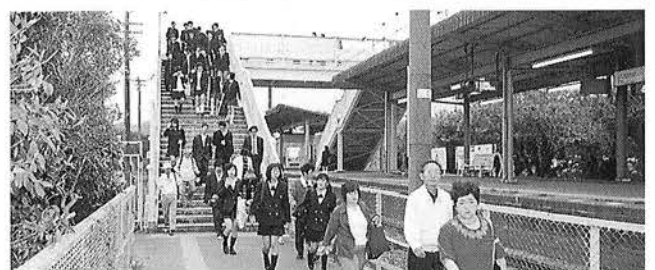
御宿駅の跨線橋に屋根が設置され、利用者の利便性向上が図られます
