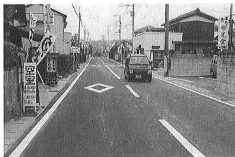
約140mの舗装工事を行った町道0101号線
