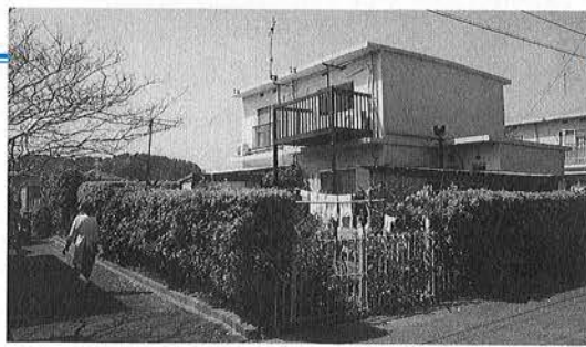
矢田団地の屋根の雨漏り防止工事を行います
