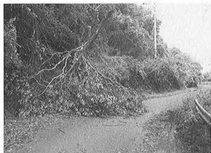
台風等の被害による復旧事業に取り組みました
