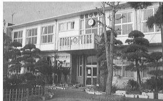
昭和31年に建設された校舎棟
