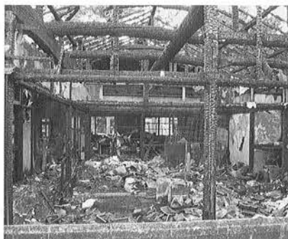
放火により全焼した（木造平屋約74平方m）旧水産加工組合事務所。
