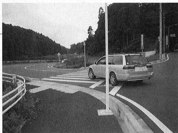
道路延長1280メートルの町道0109号線
