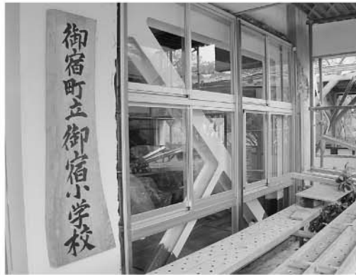
授業に支障をきたすことのないよう、夏休み期間中に大規模な工事を実施しました
