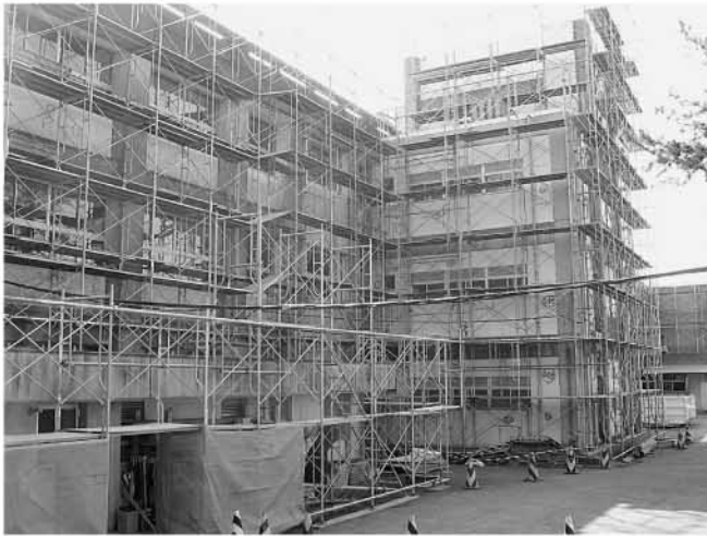
▲大規模改修工事が始まった御宿小学校
