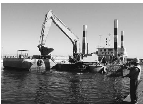
▶漁港浚渫工事の様子
