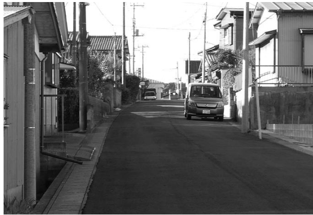
▲舗装の完了した1036号線
