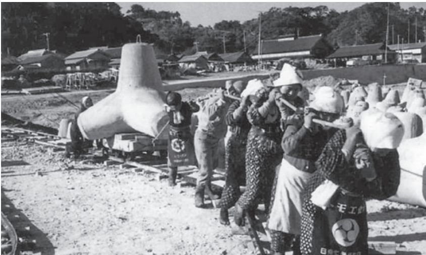
昭和38年、御宿漁港整備の様子。この年は、漁港整備をはじめ、道路舗装、中学校増築など、町発展につながる多くの公共事業が行われました。
