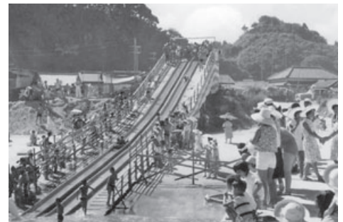
昭和39年夏、御宿漁港に設置されたボディシューター。全長50メートル、傾斜12度、時速50キロのスピードが出るとされ、海面に滑り込んでからの水上ボディスキーも楽しめたそうです。
