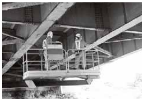
▲橋梁点検実施状況（高山田地先天神橋）
