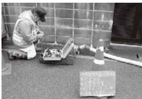
▲本管の洗浄作業
