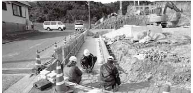
▲おんじゆく認定こども園の建設が進んでいます
