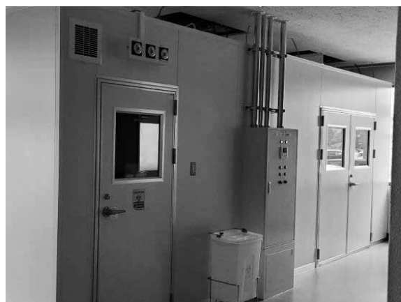
▲陰圧検査室外部
