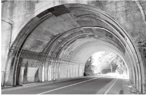
▲補修が完了した小納戸トンネル（岩和田地先）
