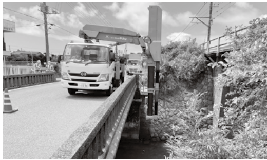
▲点検中の橋梁（久保橋）
