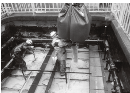
▲浄水場3号ろ過池ろ材更新工事
