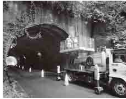
▲トンネル点検状況(西琳寺第一トンネル)
