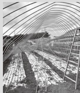
▲被災した館山市内の ビニールハウスの一部
