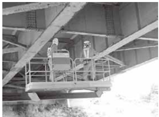
橋りょうの補修を計画的に行っていきます
