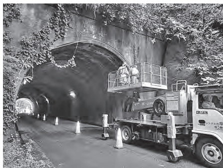
▲町内トンネルの点検の様子
