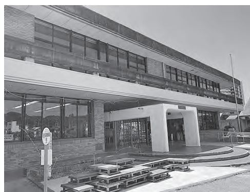
▲公民館バルコニー手摺改修工事を行います。
