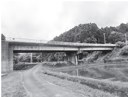
▲補修工事を行う天神橋（高山田）
